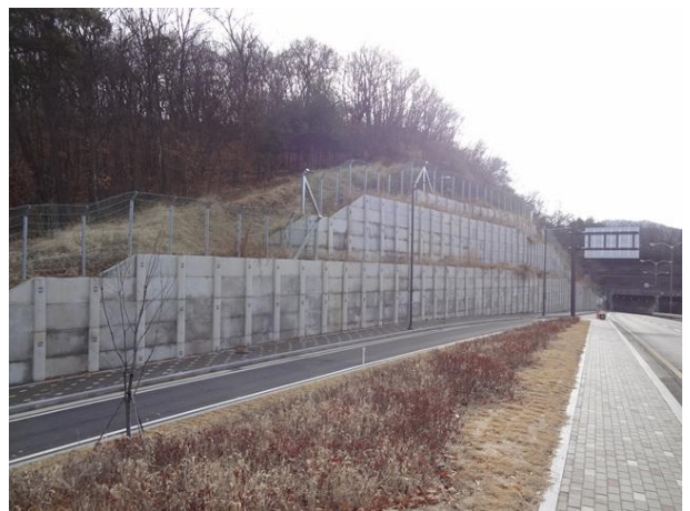
30 PC옹벽 (성남 여수지구 돌마로 연결도로, 진입로)
