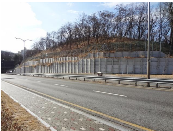
29 PC옹벽 (성남 여수지구 돌마로 연결도로, 진출로)
